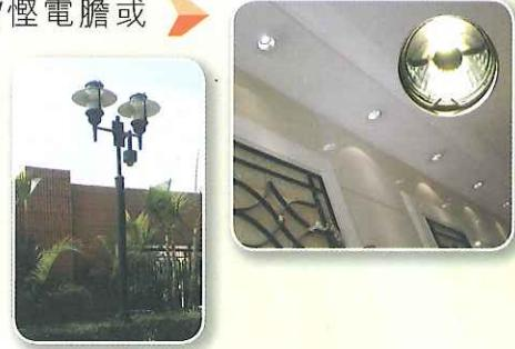
8. 將平台及羅馬廣場燈柱90個70W柱燈，更換為13W LED燈膽，節省超過80%電力；
